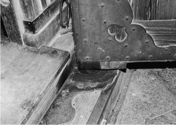
写真9 大仏殿正面扉のピボット軸受
