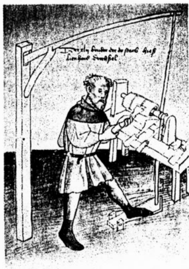
図2 ポール旋盤(1395年・Mendelsches Bruderbuch) 5) The Pole lathe in 1395. 5)
